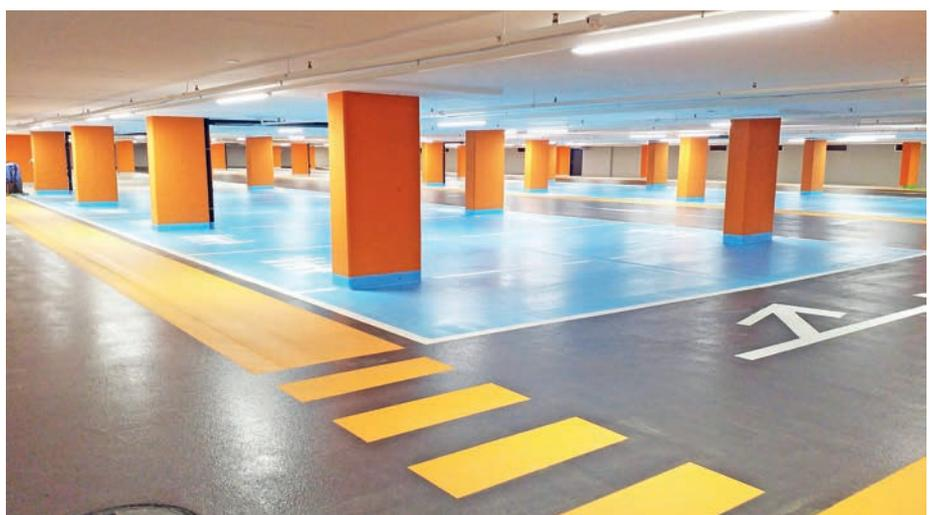
Beschichtungen für Rampen wiederum müssen hohe Rutschhemmanforderungen erfüllen und eine hohe Abriebfestigkeit aufweisen. Zudem ist hier der optimale Schubverbund äusserst wichtig. Dies kann nur mit einer richtigen Kombination von Abstreustoff und Bindemittel erreicht werden.
