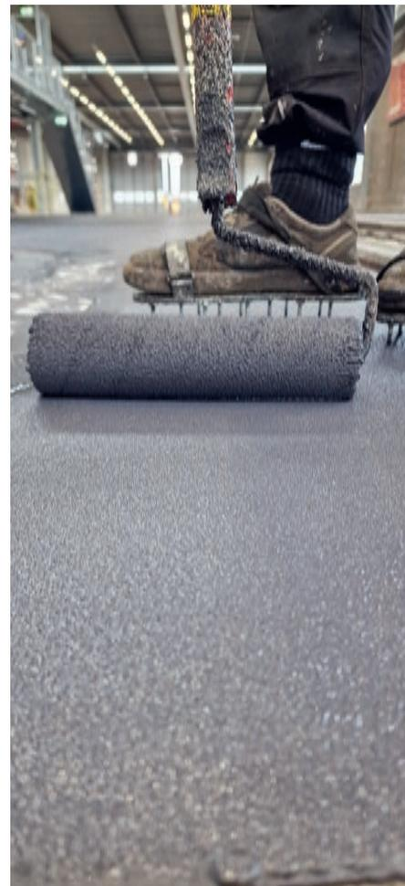
Die Mapecoat TNS Systeme werden als Schutzbeschichtung für Bodenbeläge im Innen- und Aussenbereich verwendet, die eine hohe Rutschfestigkeit erfordern, wie Treppen oder Industrieanlagen.
