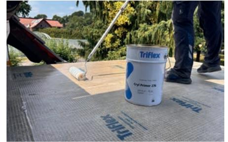
Die PMMA-basierte und ebenfalls 2-lagig aufzutragende Grundierung Triflex Cryl Primer 276 ist bei +20 °C bereits nach 45 Minuten begehbare und überarbeitbar. Epoxidharz-Grundierungen dagegen müssen 12 Stunden aushärten.
