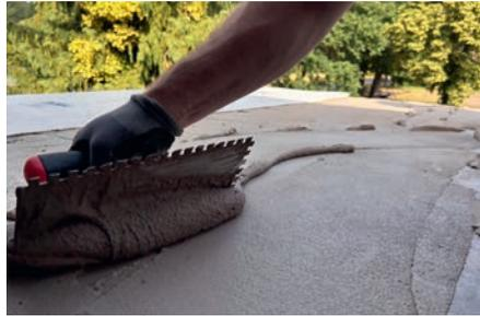
Triflex hat den Kleber, mittels dem die Entkopplungsbahn des Systems Triflex ProDrain aufgebracht wird, weiterentwickelt: Der neue Kleber Triflex ProDrain Fix+ erlaubt die Grundierung der Entkopplungsbahn bzw. das Herstellen der Lastverteilschicht mit Polymethylmethacrylat (PMMA) anstatt mit Epoxidharzen. Das verkürzt die Aushärtezeit des gesamten Systems um ein Vielfaches.
