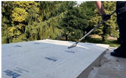
Der Kleber wird 2-lagig mit Kontaktschicht aufgetragen. Anschliessend kann die Entkopplungsbahn DC-Mat in das Klebebett ausgerollt und vollflächig verklebt werden.
