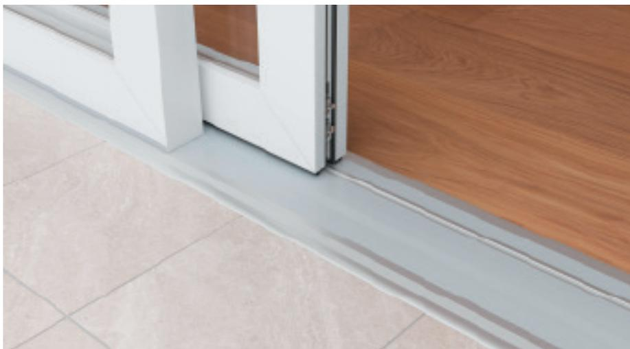
Im Sinne einer barrierefreien Lösung ist eine dauerhaft funktionsfähige Abdichtung im Übergangsbereich gefragt. Ein integriertes Spezialvlies sorgt für Elastizität und gleicht Bauwerksbewegungen aus.
