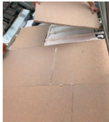
Zur Vermeidung von Wärmebrücken eignet sich Triflex BIS, eine Kombination von Abdichtungs- und Dämmsystem. Dünnschichtige expandierte Polystyrolhartschaumplatten-Platten (EPS) stellen die notwendige Isolierung sicher, während die integrierte Abdichtung auf PMMA-Basis die Bausubstanz zusätzlich vor Feuchteintrag schützt.
