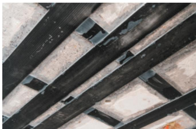
Strukturelle Verstärkung von Decken und Böden eines Einfamilienhauses mit Carboplate-Lamellen.
