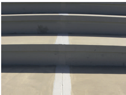
Bewegungsfugen werden mit einer Schlaufenausbildung versehen. Diese füllen Verarbeiter mit elastischem Material. Die anschliessend eingesetzte PE-Rundschnur kleben sie mit Steinklebeband ab, um dann die Abdichtung aufzubringen.
