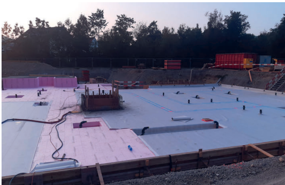
Einbau von Maapeproof FBT im Hallenbad in Appenzell
