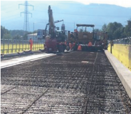
Abb. 09: Brückenbewehrung
