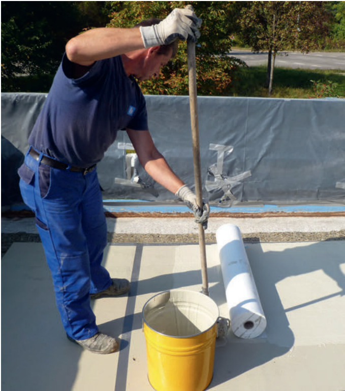
Für die Applikation von Flüssigkunststoff-Produkten reicht eine Universalrolle in der Regel aus. Die Verarbeitung ist auch bei niedrigen Temperaturen bis 0 °C (bzw. bei Detailabdichtungen bis -5 °C) möglich.
