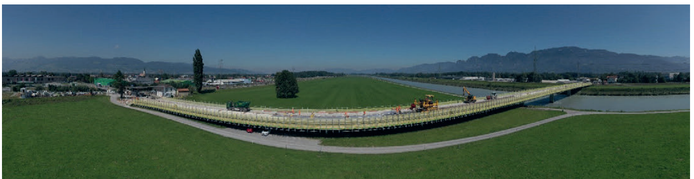
Abb. 08: Maschinelles Einbau mit Gleitschalungsfertiger (ganze Brückenlänge)
