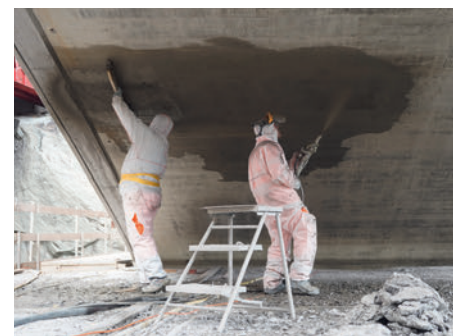
Aufbringen von Mapegrout Tissotropico im Nassspritzverfahren
