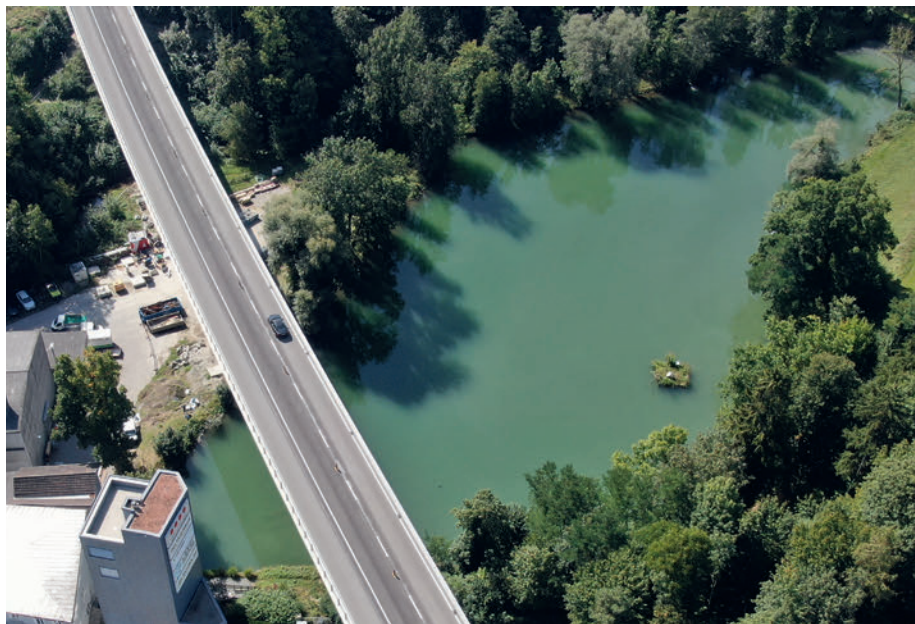
Der Erddamm unter dem Viadukt Mühle hält eine ansehnliche Wassermenge zurück
