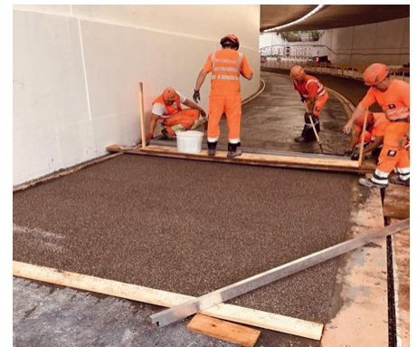
Abb. 06: Abgestreut mit Splitt
