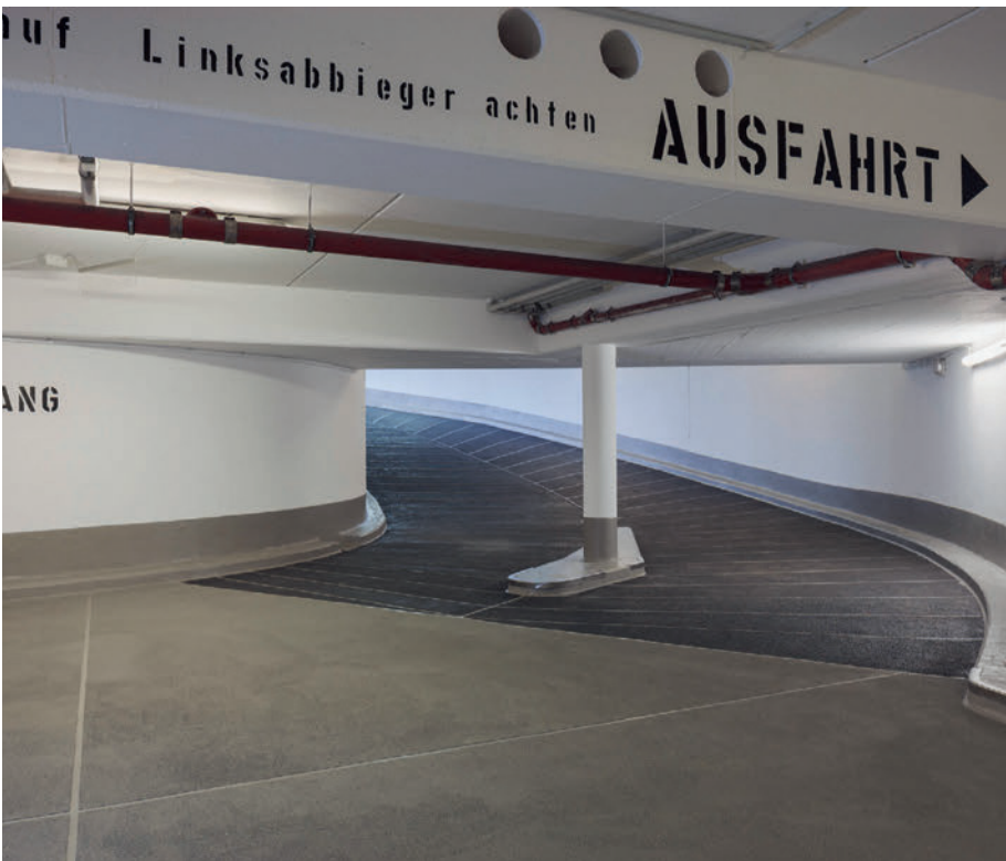
Lösungen auf PMMA-Basis gehen eine vollflächige Haftung mit dem Untergrund ein. Durch die Einstreuung von Quarzsand werden eine hohe Rutschhemmung und ein hoher Verschleisswiderstand erzielt.
