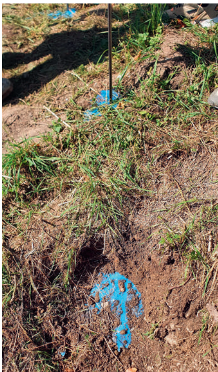
Das niederviskose Hydrostrukturharz dichtet sämtliche Verästelungen ab
