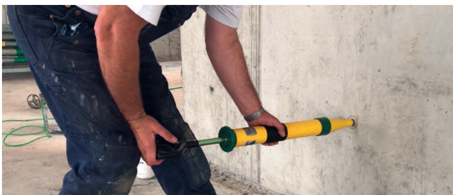
Spannstelle verfüllen
