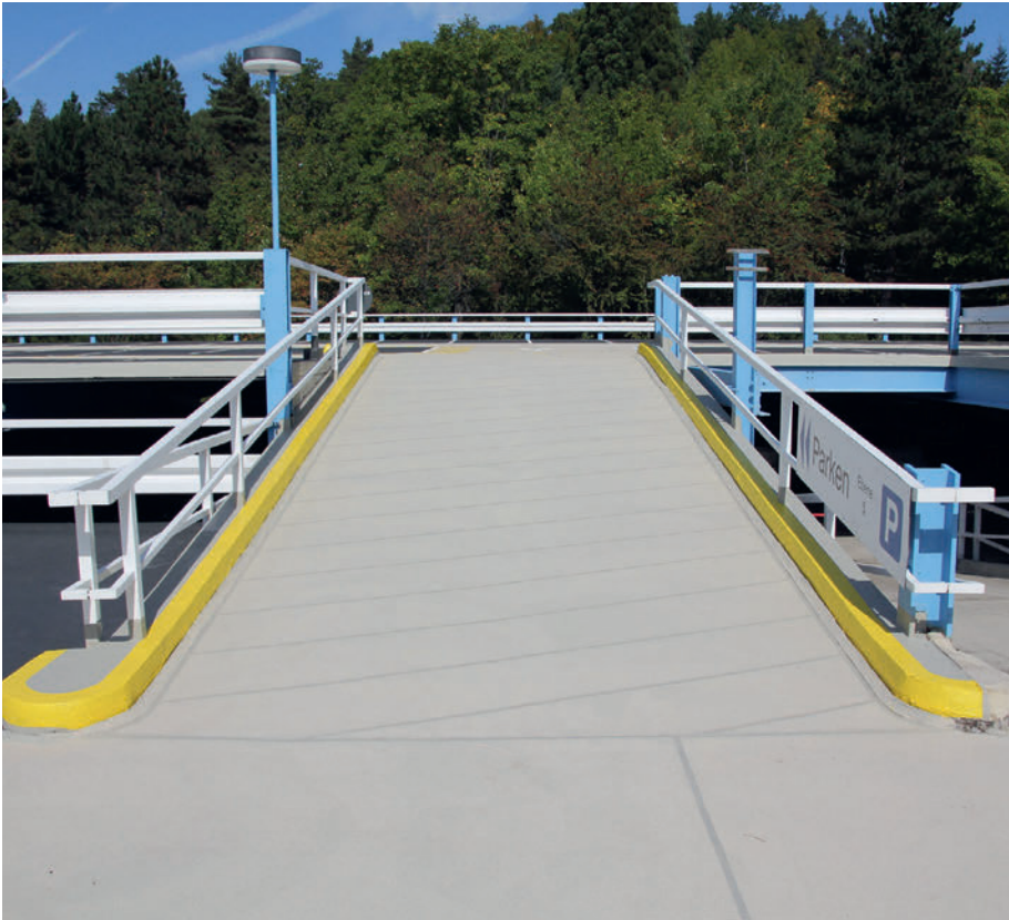
Schnell reaktives Polymethylmethacrylat (PMMA) haftet auf verschiedenen Untergründen und verkürzt die Ausführungs- und Sperrzeiten. Es ermöglicht so eine wirtschaftliche Sanierung ohne Abriss.
