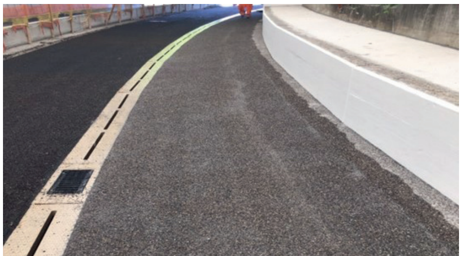
Abb. 07: Abgestreuter Belag mit UHFB
