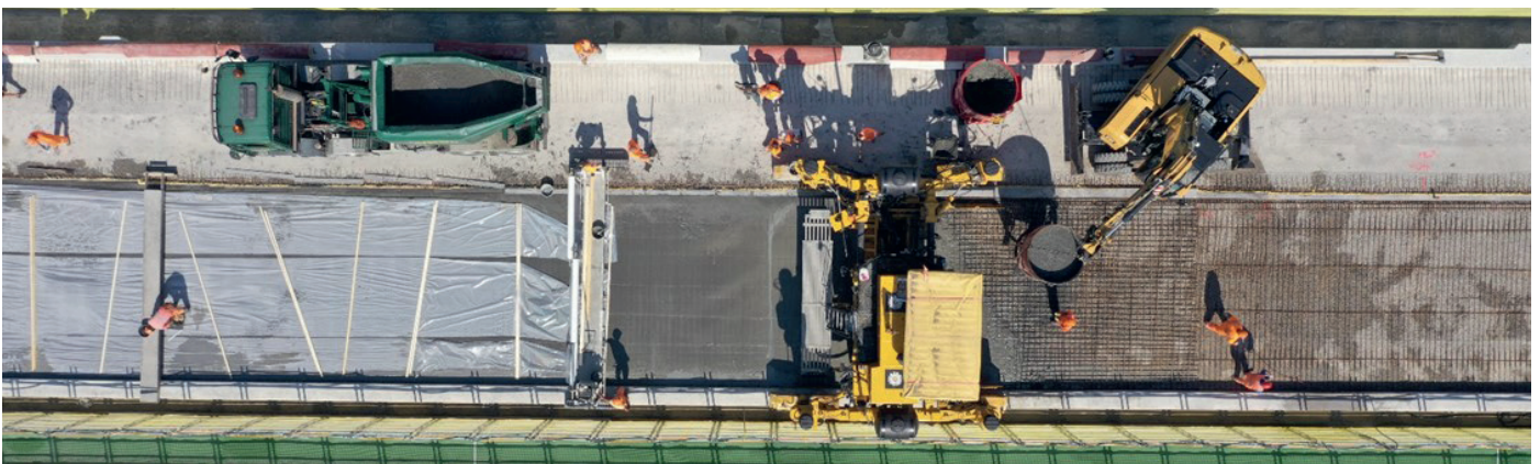
Abb. 13: Maschineller Einbau mit Gleitschalungsfertiger in der Vogelperspektive
