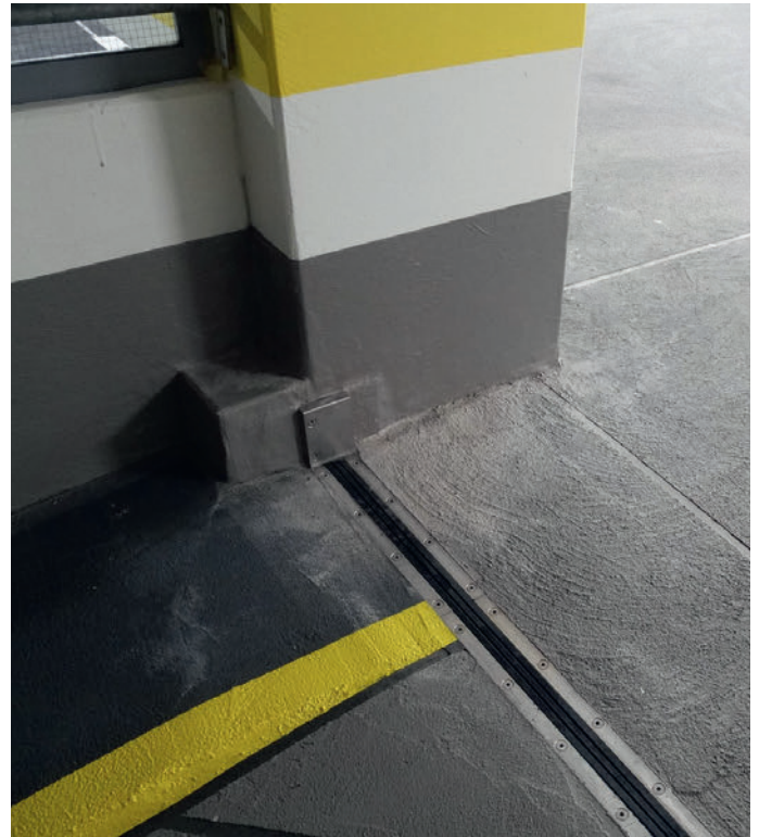
Details wie Stützpfeiler, aber auch Fugen und Schrammborde stellen eine Schwachstelle in der Konstruktion dar, da hier verstärkt Rissbildung auftreten kann. Flüssigkunststoff-Lösungen können auch an Übergängen zu vertikalen Bauteilen aufgebracht werden und dichten dort ebenso dauerhaft und zuverlässig ab.
