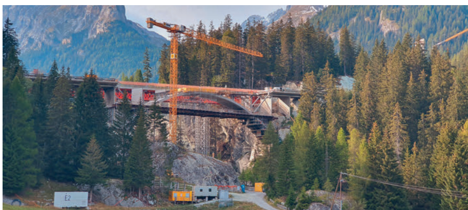
Sanierung der Crestawaldbrücke in Sufers
