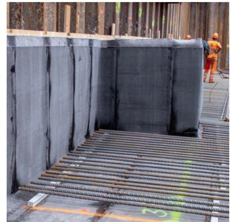
Das Abdichtungssystem konnte so gewählt werden, dass die gesamte aussenliegende Abdichtung um die Bauwerke aus einem durchgehenden homogenen Material besteht (Polymerbitumenbahnen) und so verschiedene Materialübergänge vermieden werden konnten. Insbesondere bei den Sichtbetonwänden konnte mit diesem System die Abdichtung nach dem Betonieren appliziert werden und hat somit den Arbeitsablauf erheblich vereinfacht.
