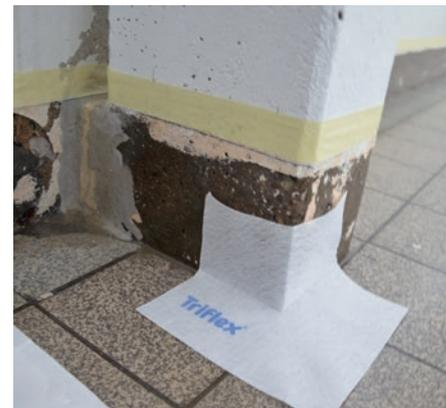
*Dank Vliesarmierung sowie der flüssigen Verarbeitungstechnik schmiegen sich die Abdichtungslösungen wie eine zweite Haut an alle Geometrien an und schützen das Bauwerk langzeitsicher vor Feuchtigkeitsschäden.*
