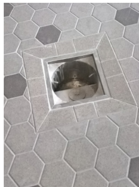
Für Bodenabläufe wie auch bei Boden-Wandanschlüssen kamen die Dichtbänder und Dichtecken PCI Pecitape in Verbindung mit PCI Apoflex F für die sichere Abdichtung zum Einsatz.
