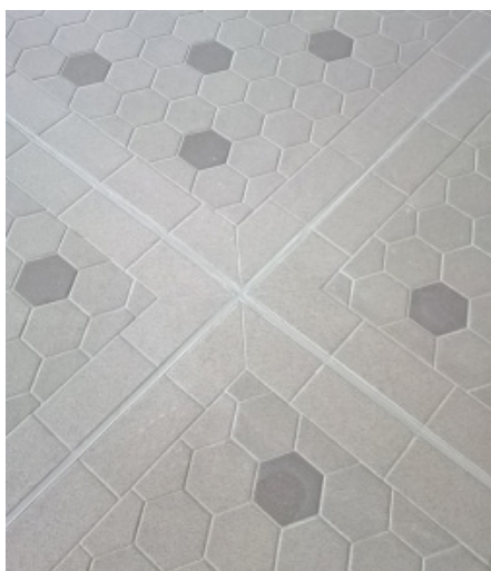
Gefällskorrekturen führten die Verarbeiter im Untergrund mit PCI Pericret aus. Die Dehnfugen wurden mit PCI Elritan 140 bewerkstelligt.
