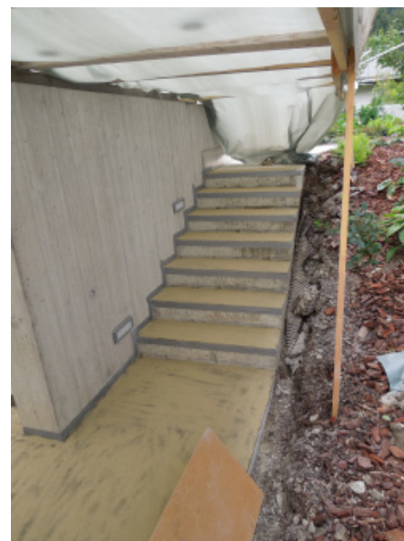
Zur Aufnahme des Epoxidharzmörtels wird vorgängig eine Epoxidgrundierung auf den vorbereiteten Untergrund aufgetragen, abgesandet mit feuergetrocknetem Quarzsand.
