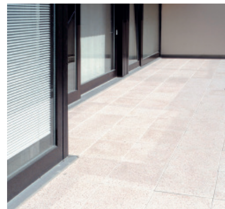
Der Abbau von Schwellen bei Übergängen von Wohn- zu Aussenräumen gelingt mit den Sonderlösungen aus Flüssigkunststoff – auch unter Fremdbelag, wie beispielsweise Fliesen.
