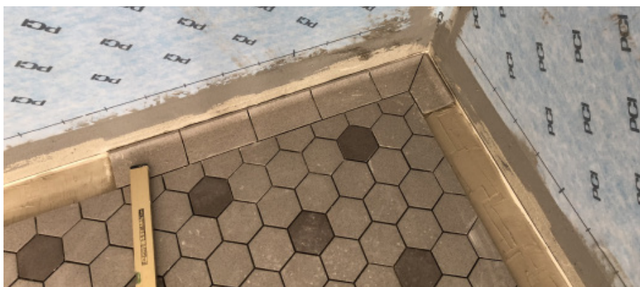
Den Boden-Wandanschluss führten die Verarbeiter mit Hohlkehlsöckel aus.
