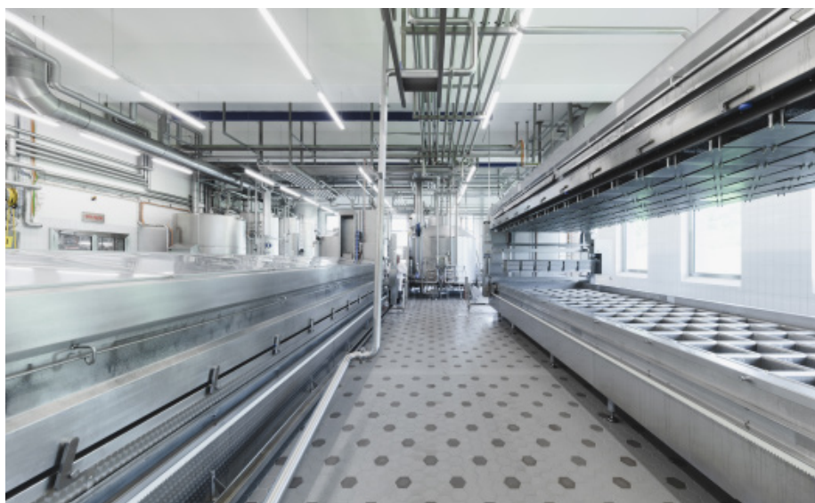
Als Oberbelag wählte die Bauherrschaft Sechseck-Platten. Diese sind gerade in hochbelasteten Industriebereichen aufgrund ihrer Langlebigkeit von grossem Vorteil. Die beauftragte Dillier Feuer + Platten AG verklebte sie mit PCI Flexmörtel S1 Flott.
