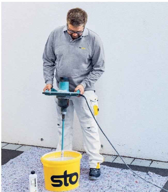
Das neue Sto-Additiv QS wird bei Bedarf in die vorhandenen Fassaden- resp. Betonfarbe gemischt.
