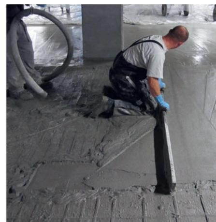
Die Oberfläche des frisch eingebauten Instandsetzungsmörtels PCI Nanocret R4 SA wird mit einem Vibrationsbalken verdichtet und gleichmässig abgezogen. Abschliessend werden die Oberflächen mit einem Flügler geglättet.
