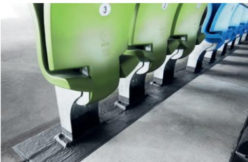
Als Schnittstellen zwischen den Bauteilen sind die Fugen, z. B. auf den Tribünen, besonderen Belastungen ausgesetzt. Sie müssen in eine flexible Abdichtung eingefasst werden, um den Komplex vor Feuchteintritt zu schützen.
