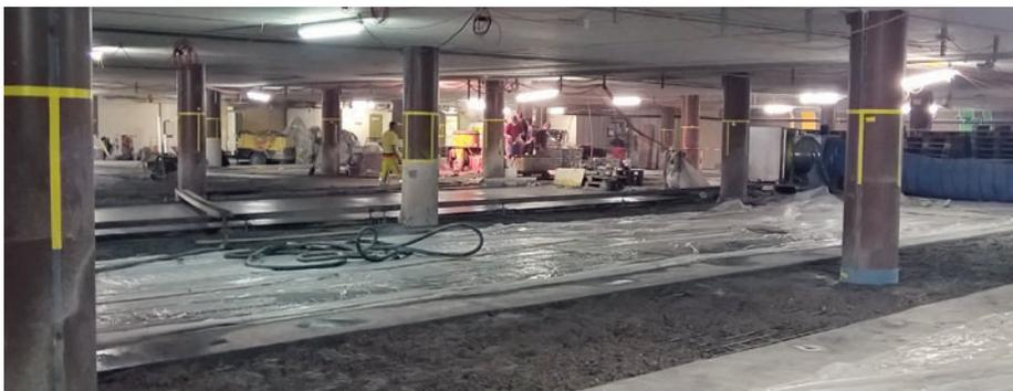
Gut zu sehen sind die Anodenbänder die in Streifen auf dem zu beschichteten Boden fixiert wurden. Auf den mattfeuchten Untergrund wird eine Haftbrücke aus Eigenmaterial des Betoninstandsetzungsmörtels PCI Nanocret R4 SA aufgetragen. Anschliessend wird der frische Mörtel in die noch frische Mörtelhaftbrücke «frisch in frisch» eingebaut.
