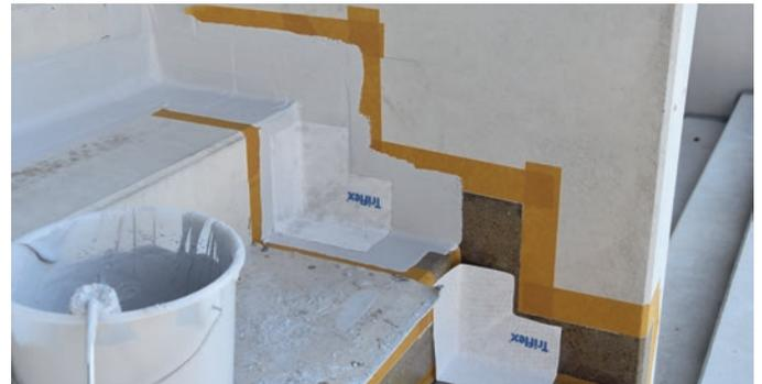
Systemlösungen aus Flüssigkunststoff bewähren sich in der Baupraxis seit vielen Jahren. Wie eine zweite Haut legen sie sich an die Konstruktion an und schützen diese zuverlässig vor Abnutzung und Feuchteschäden.
