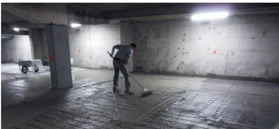
Mörtel mischen, pumpen, nivellieren und entsprechend der Vorgaben der Planer, die Oberfläche für die nachfolgende Parkdeckbeschichtung bearbeiten.
