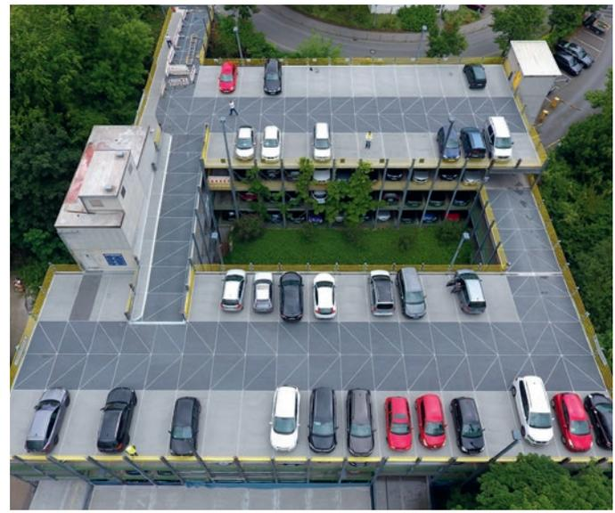
Von der Tiefgarage bis zum Freideck – Flüssigabdichtungen auf PMMA-Basis schützen zuverlässig und dauerhaft. Daraus resultieren eine Wertsteigerung und ein Werterhalt der Immobilie über die geplante Nutzungsdauer.
