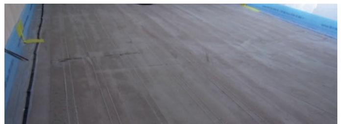
Verfüllen von Fugen und Rissen inkl. Grundierung der Böden mit PCI Gisogrund 404 und PCI STL 39
