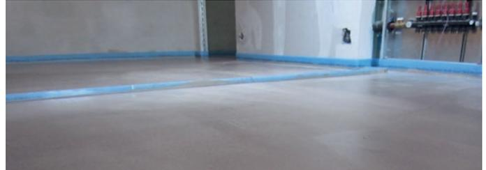
Ausgleichsmasse PCI Periplan Extra direkt auf das Heizsystem gegossen (Rohrüberdeckung von 5 mm)
