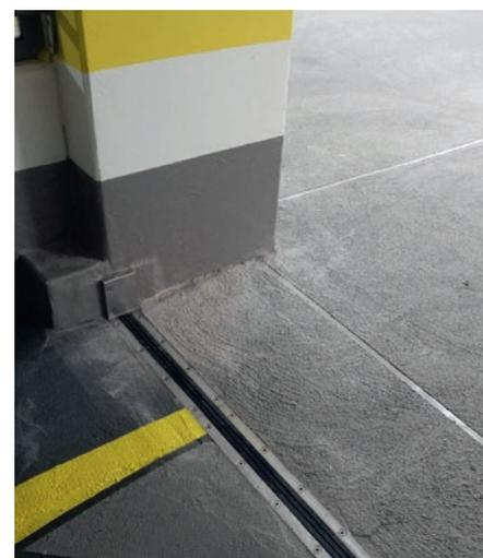
*Details wie Stützpfeiler, aber auch Fugen und Schrammborde stellen eine Schwachstelle in der Konstruktion dar, da hier verstärkt Rissbildung auftreten kann. Flüssigkunststoff-Lösungen können auch an Übergängen zu vertikalen Bauteilen aufgebracht werden und dichten dort ebenso dauerhaft und zuverlässig ab.*
