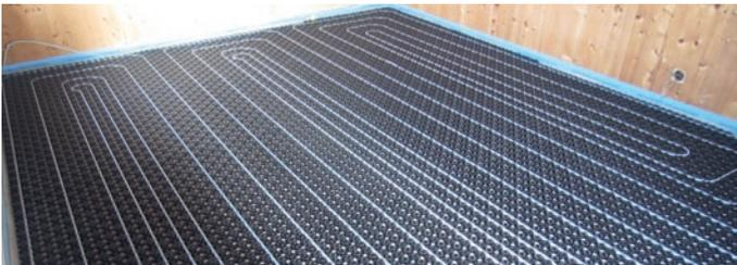
Niedertemperaturheizsystem verlegt auf dem schwimmenden Estrich. Noch ohne Ausgleichsmasse.
