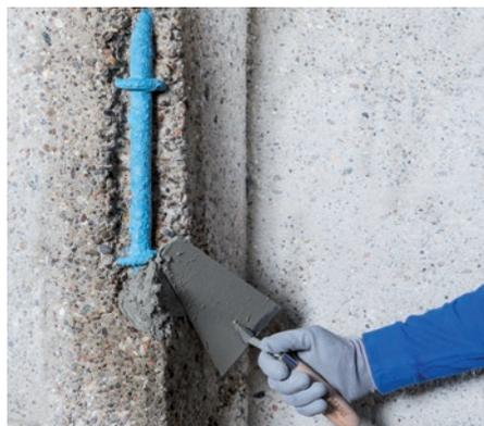
PLANITOP RASA & RIPARA R4 ist ein Mörtel zur Reparatur und Egalisierung von Beton.
