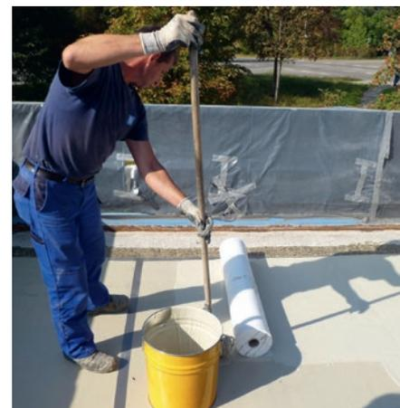
*Für die Applikation von Flüssigkunststoff-Produkten reicht eine Universalrolle in der Regel aus. Die Verarbeitung ist auch bei niedrigen Temperaturen bis 0 °C (bzw. bei Detailabdichtungen bis -5 °C) möglich.*
