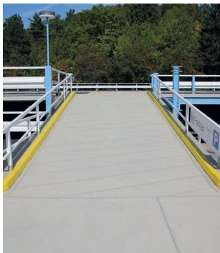
*Schnell reaktives Polymethylmethacrylat (PMMA) haftet auf verschiedenen Untergründen und verkürzt die Ausführungs- und Sperrzeiten. Es ermöglicht so eine wirtschaftliche Sanierung ohne Abriss.*
