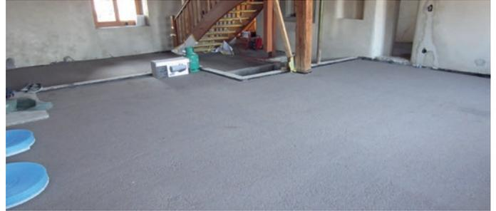
Schwimmender Estrich auf der Bitumenbahn nach spezieller Rezeptur.
