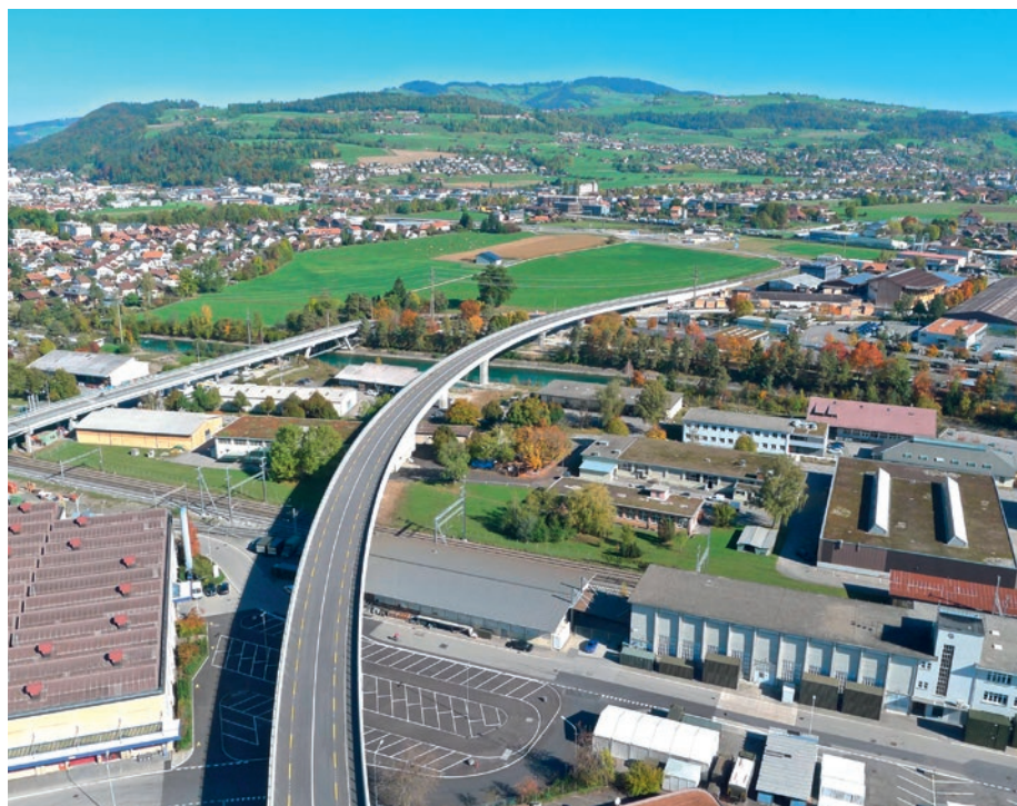
DYNAMON SR 914 CH, DYNAMON SR 912 CH und MAPEAIR AE 205 wurden zur Herstellung der verschiedenen Betonsorten für die Fundamente, Pfeiler, den Hohlkasten, die Brückenplatte und die Bordüren der Brücke geliefert.
