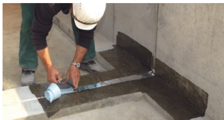
Nach der Untergrundvorbereitung und der Grundierung bringen Handwerker Steinklebeband auf, damit bei der folgenden Abdichtung keine Zwischenhaftung entsteht.
