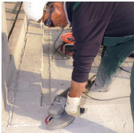
Für WU-Betonfugen eignen sich speziell entwickelte Abdichtungssysteme auf Polymethylmethacrylat-Basis (PMMA). Um diese auf den vorhandenen Belag aufzubringen, schleifen Fachverarbeiter den Beton zunächst an.
