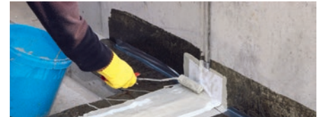
Frisch in frisch arbeiten Abdichtungsspezialisten die Vliesarmierung in den Flüssigkunststoff ein. Dadurch ist das überlappende System elastisch und unterlaufsicher.
