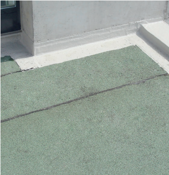
Besonders bei der Abdichtung von Details spielt Flüssigkunststoff seine Vorteile aus. Mit dem Material können Verarbeiter Stützen, Abläufe oder Wandanschlüsse homogen in die Fläche integrieren
