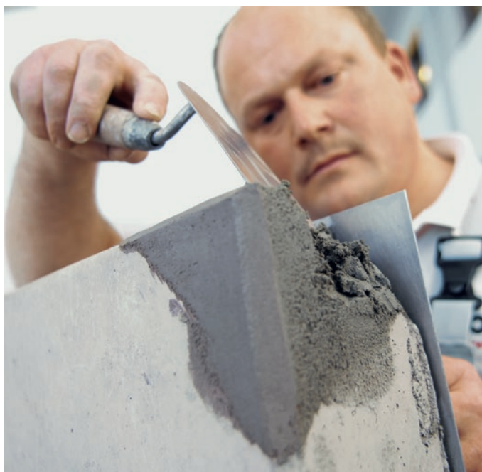
Mit dem Schnellreparaturmörtel StoCrete SM ist die Reprofilierung einer Betonkante kein Problem.
