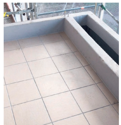
Durch den niedrigen Aufbau von nur wenigen Millimetern bieten sich flüssige Abdichtungssysteme zum barrierefreien Bauen an. Auch wenn ein Fremdbelag wie Fliesen aufgebracht werden soll, lassen sich schwellenlose Übergänge realisieren.
