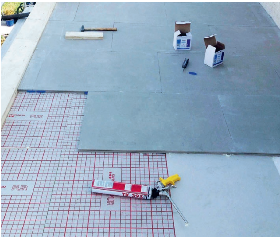
Im Zuge von Sanierungen kann mit einer Wärmedämmung die Energiebilanz von Gebäuden verbessert werden. Da eine flüssige Abdichtung nur eine minimale Schichtstärke hat, kommt der Grosseil der verfügbaren Aufbauhöhe der Dämmung zugute
