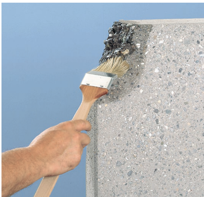
Vor dem Mörtelauftrag wird der Untergrund mattfeucht vorgegänst.
