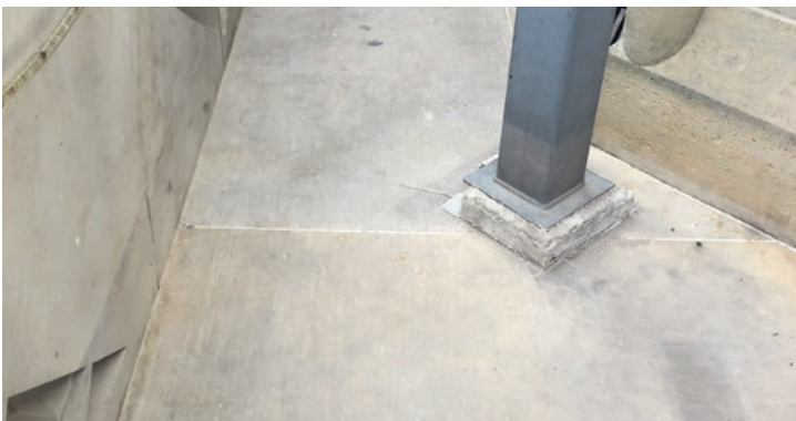
Besonders bei der Abdichtung von Details spielt Flüssigkunststoff seine Vorteile aus. Mit dem Material können Verarbeiter Stützen, Abläufe oder Wandanschlüsse homogen in die Fläche integrieren
