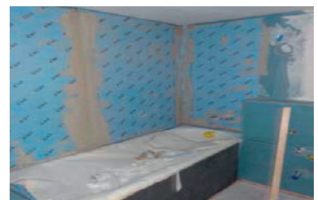
Bild A: Abgedichteter Untergrund (Duschbereich)
