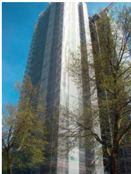
Kopfbau mit Baugerüst
