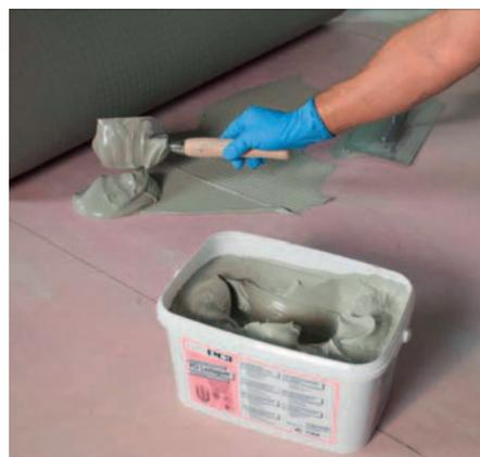
*Komfortable Verarbeitung: Die parallel verlaufenden Noppen erleichtern das Verlegen der Bahn enorm. Für das Verkleben der PCI Pecilastic E auf Anhydritestrichen mit einer Restfeuchte kleiner 2 % CM empfiehlt PCI die wasserdichte Schutzschicht PCI Lastogum oder den neuen universellen Parkettkleber PCI Colliflex.*
