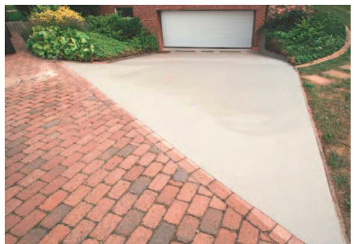
Der verwendete Strukturbelag als Oberbelag sorgt für sicheren Grip.
