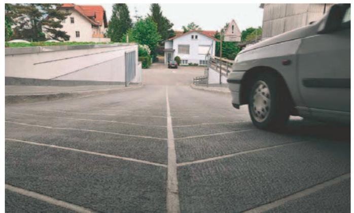
Am nächsten Morgen ist die 160m<sup>2</sup> grosse Rampe fertig saniert. Die Nutz-Ebene aus mechanisch hochbeständigem Strukturbelag sorgt für dauerhaften Grip.
