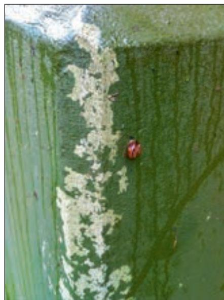
Als Zweites wurde eine Begehung vor Ort angesetzt, um das genaue Schadensmass festzustellen und eine ausführliche Fotodokumentation zu erstellen. Wie oben beschrieben, zeigten sich Ablösungen der Beschichtung vom weissen, mineralischen Untergrund. Blasenbildungen auf dem Beton oder Abplatzungen des mineralischen Untergrundes selbst konnten allerdings nirgends gesichtet werden. Wir konnten jedoch feststellen, dass sich die Beschichtungsschäden vorwiegend auf Sockel in Waldbereichen be-
