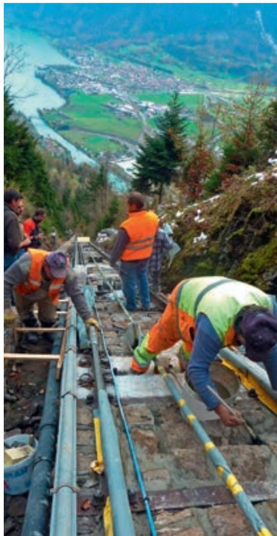
Repafast® Tixo sowie für den fließfähigen Reparaturmörtel PCI Repafast® Fluid. Beide Produkte lassen sich bis  $-10^{\circ}\text{C}$  verarbeiten und sind somit exzellent an die schwierigen Sanierungsbedingungen angepasst. Entsprechend positiv sind auch die ersten Erfahrungen aus der Sanierungsphase. Und im nächsten Winterhalbjahr werden die Sanierungsarbeiten weitergehen. Damit wartet dann bereits die nächste Bewährungsprobe auf Mitarbeiter und Material.
