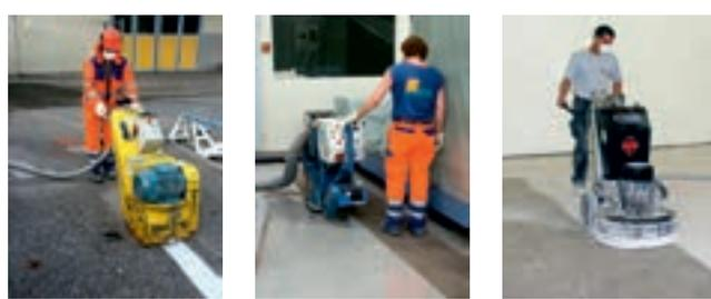
**Kugelstrahlen, Demarkierung, Aufrauen, Schleifen, Zementhaut entfernen.**
