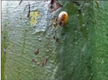
Bei der näheren Untersuchung der entnommenen Beschichtungsproben kamen weitere interessante Details zu Tage. So zeigte sich, dass viele der kleinen Schnecken-Kote grün gefärbt waren, im gleichen Farbton wie jener der Beschichtung. Ausserdem waren die Kotproben hoch elastisch. Hielt man ein Ende eines «Pröbchens» fest, so konnte man den restlichen Teil um 180° biegen. Liess man dieses dann los, so schnellte es sofort in seine Ausgangsposition zurück.
