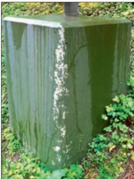
Vor einiger Zeit wurde dann bei einer Routinekontrolle festgestellt, dass die Beschichtung an diversen Stellen, besonders aber entlang von Kanten, Beschädigungen aufwies. Diese zeigten sich gemäss Kundenaussage durch grössere und auch kleinere Abplatzungen der Beschichtung vom Beton (also vom mineralischen Untergrund). Die Ursache
