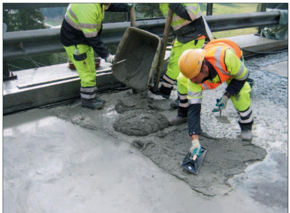
Einbau des Reprofiliermörtels
