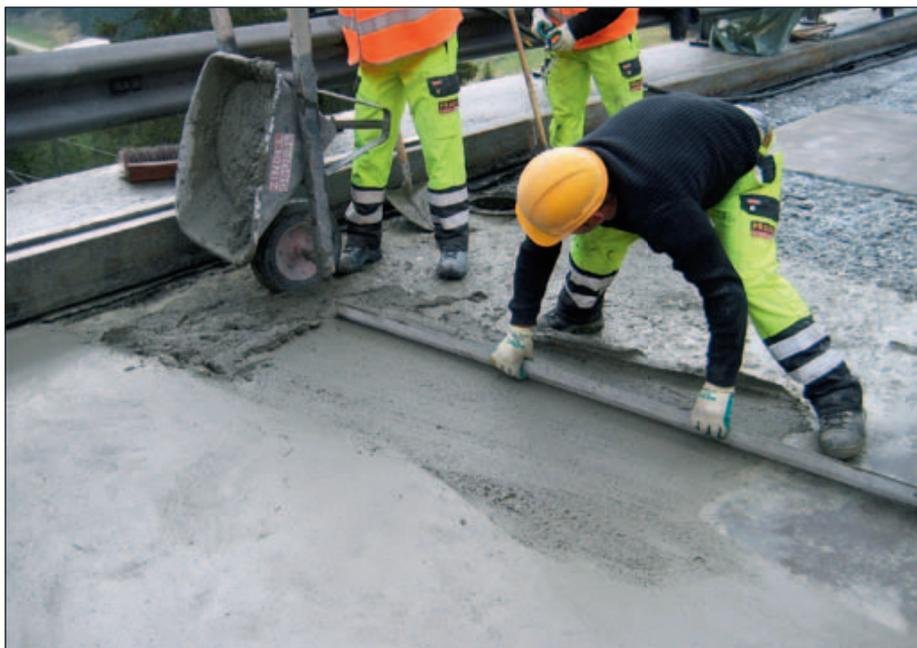
Einbau des Reprofiliermörtels
