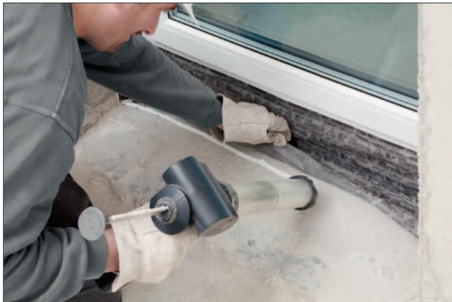
Luftdicht aber dampfdiffusionsoffen – und das nach Bedarf: Die Fensterabdichtungsfolie wurde speziell für diffizile bauphysikalische Verhältnisse entwickelt (Rehau).
