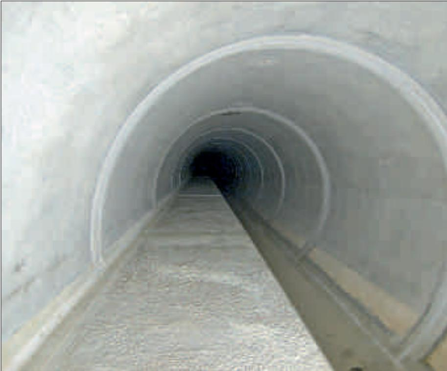
Abgedichtete Fugen in einem (Löschwasser-) Rückhaltestollen, Dreispitzareal Basel.
