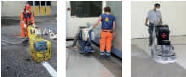
**Kugelstrahlen, Demarkierung, Aufrauen, Schleifen, Zementhaut entfernen.**
