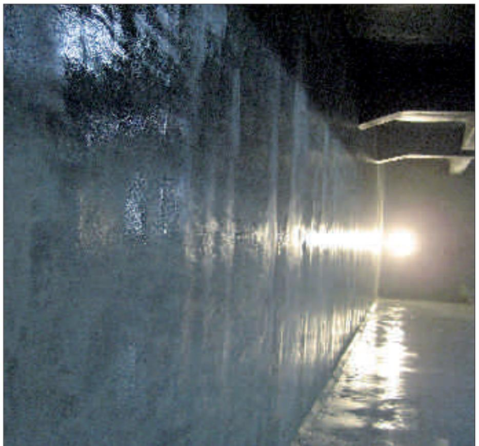
Kammer 3, Reservoir Lauenen, fertig beschichteter Trinkwasserbehälter kurz vor Inbetriebnahme
