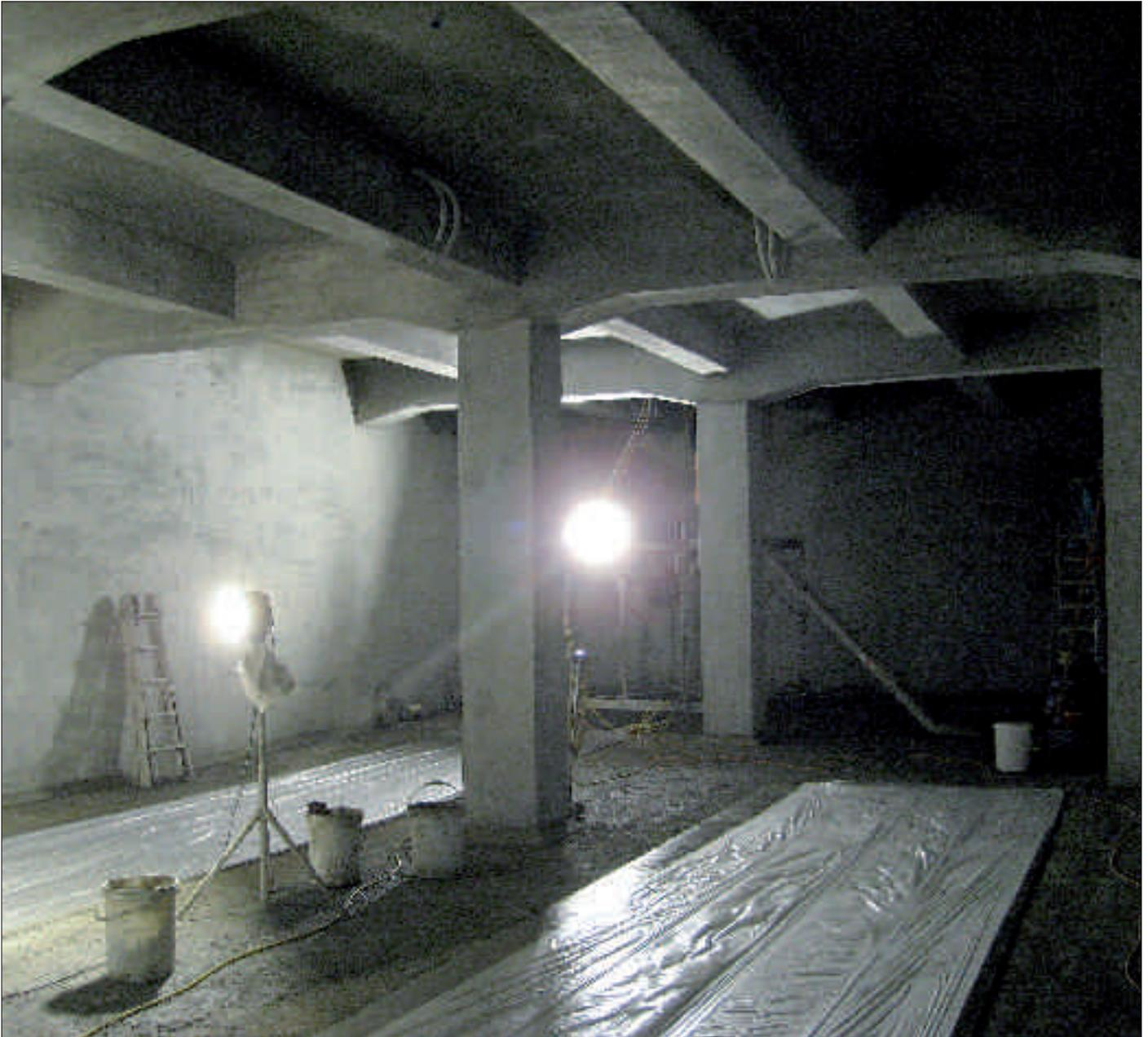
*Bodenbeschichtung in Bahnen mit zusätzlicher Nachbehandlung durch Abdecken mit Plastikfolie*
