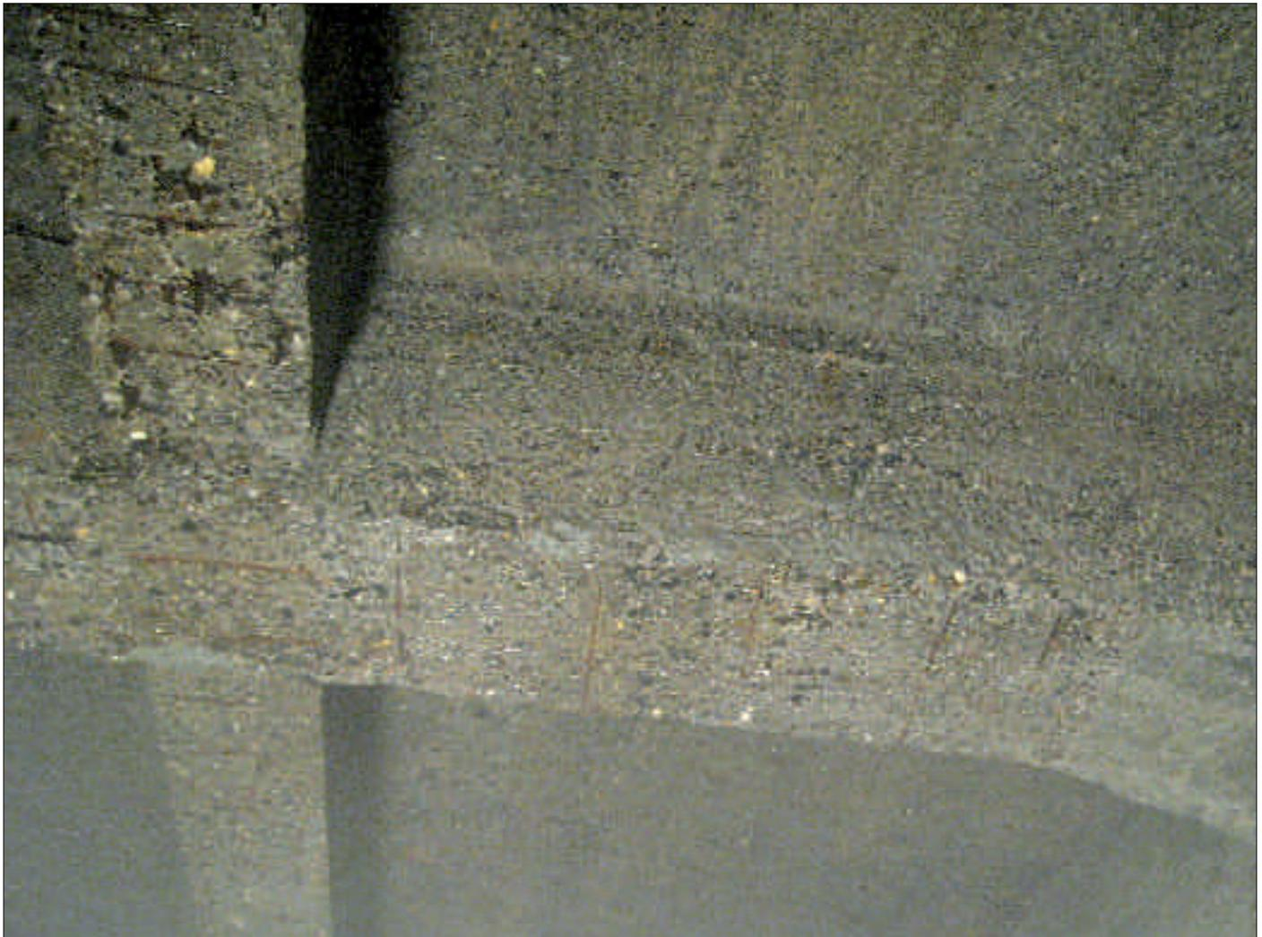
Vorbereiteter Betonuntergrund mit Höchstdruckwasserstrahlen
