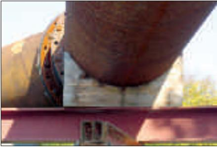
Holz-sattel bei Stützenauflager
