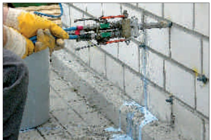
Bild 3: Injektion in den Versuchsaufbau über Schlagpacker
