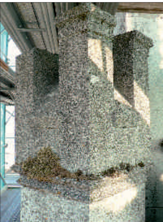
Bild 4: Eckdetail aus Kunststein nach mehr als 70 Jahren Freibewitterung
