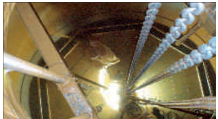
Spritzapplikation auf Arbeitsbühne, erste Lage
