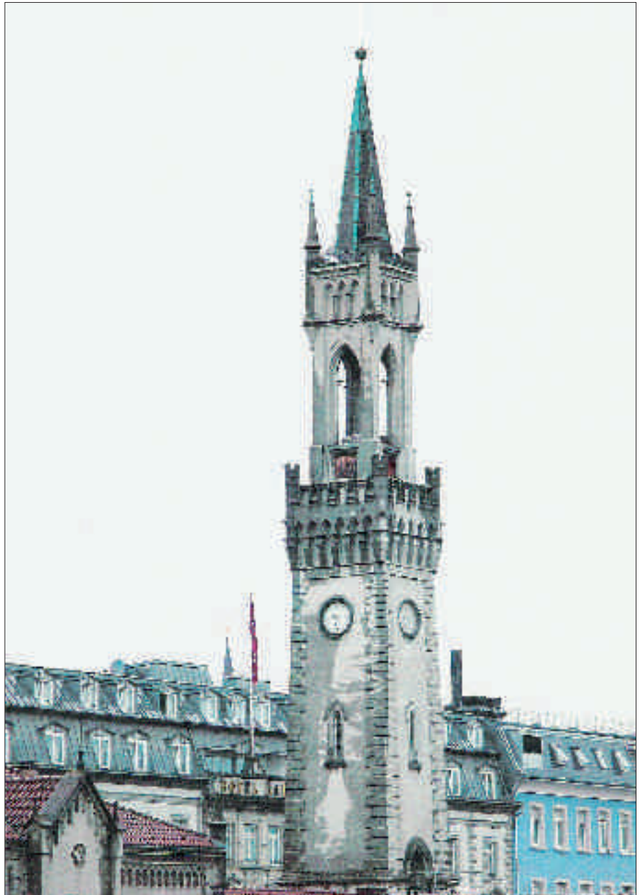
Bild 1: Ansicht des Bahnhofsturms (Südseite) vor der Sanierung
