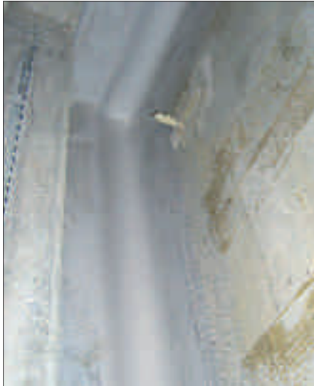
Bild 5: Ausschnitt der luftdichten Fugenkonstruktion im Bereich eines künftigen Durchganges.
