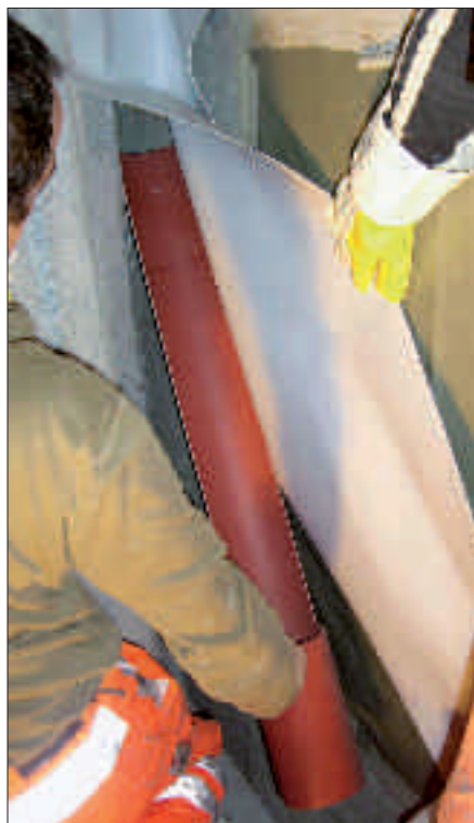
Bild 3 und 4: Schablone als Verlegehilfe für die Schweißungen der Bandenden vor Ort
