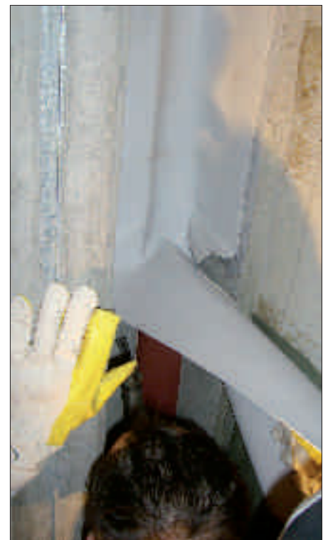
Bild 3 und 4: Schablone als Verlegehilfe für die Schweißungen der Bandenden vor Ort
