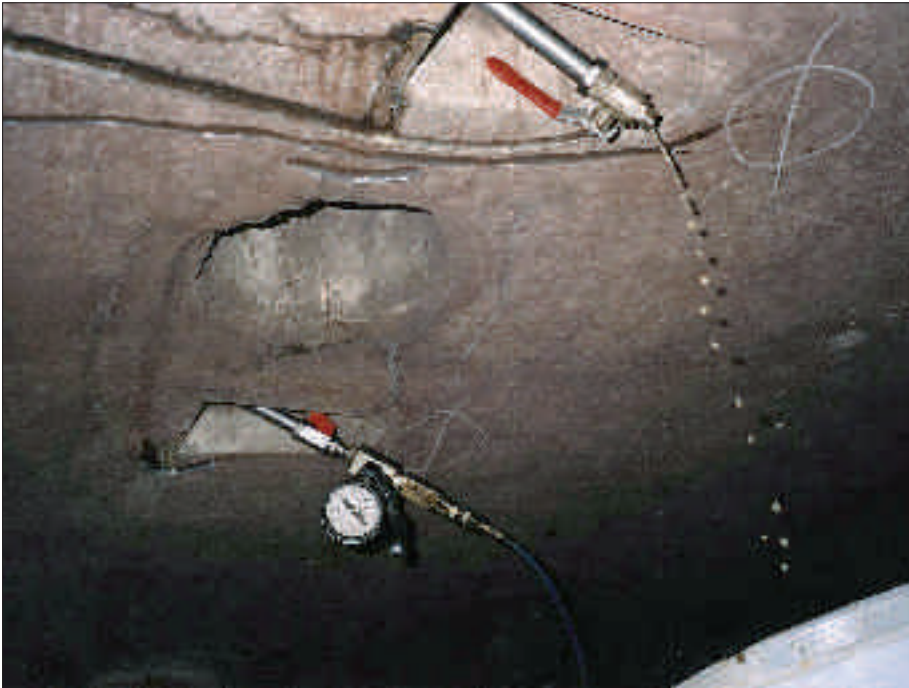
Bild 11: Injektion über Verschraubungsöffnungen in der 4. Röhre Elbtunnel, Hamburg
