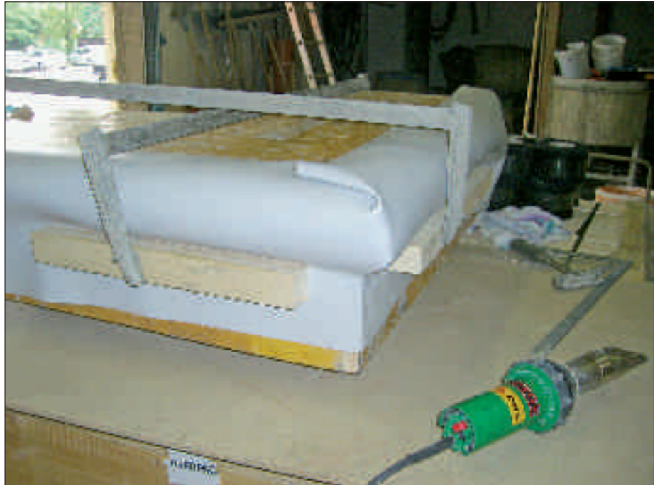
Bild 2: Mit Hilfe von Schablonen im Werk vorgefertigte Eckbereiche
