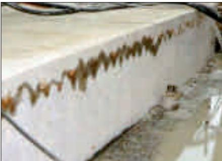
Bild 2: Wasserfließwege entlang der Bewehrungsstäbe einer Bodenplatte (Foto DMI)
