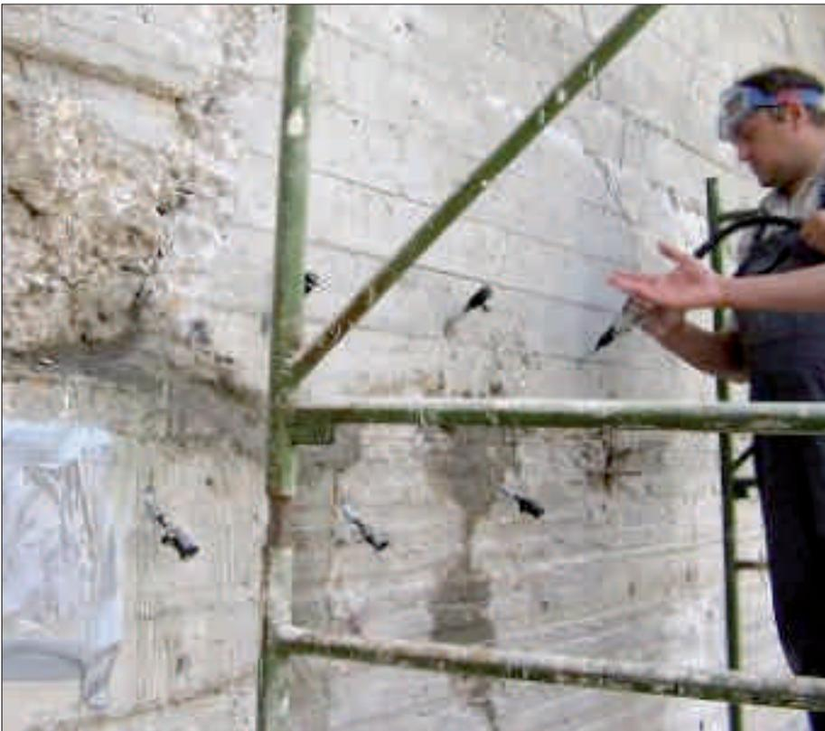
Bild 20: Injektion einer Zementsuspension
