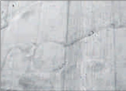
Bild 1: Fehlstellen und Grobkornanreicherungen an Betonierabschnitten einer Tunnelwand
