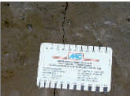
Bild 8: Von Wasser durchströmter Trennriss
