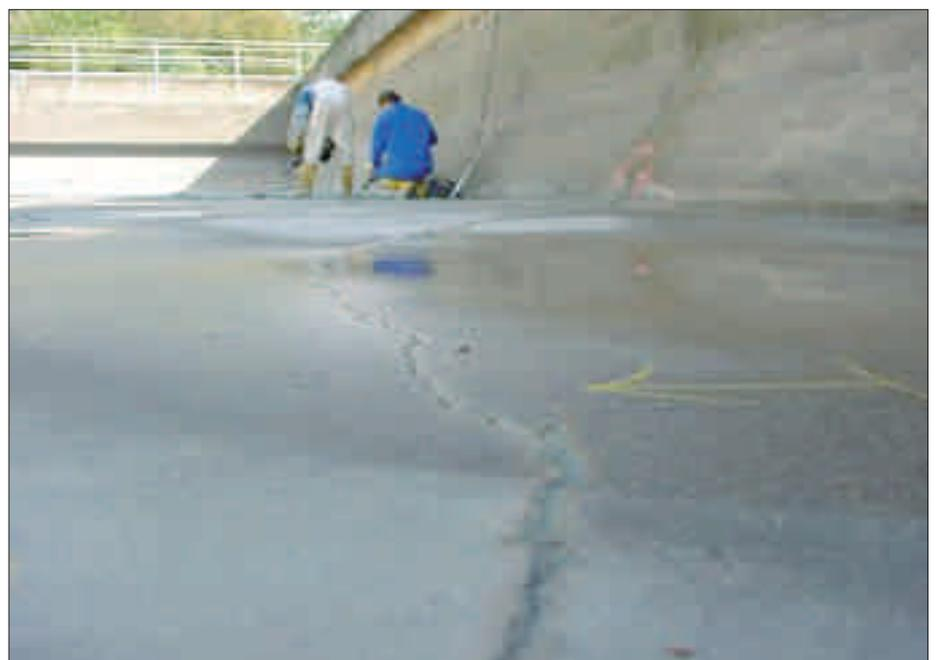
Bild 13: Wasser führende Trennriss in der Bodenplatte einer Kläranlage (Foto KST)
