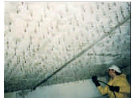
Bild 15: Rasterinjektion an der Decke einer Tiefgarage
