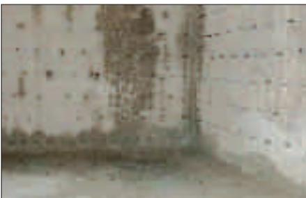
Bild 3: Durchfeuchteter Beton (mit Packern bestückt)
