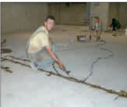
Bild 17: Injektion von Rissen über Klebepacker
