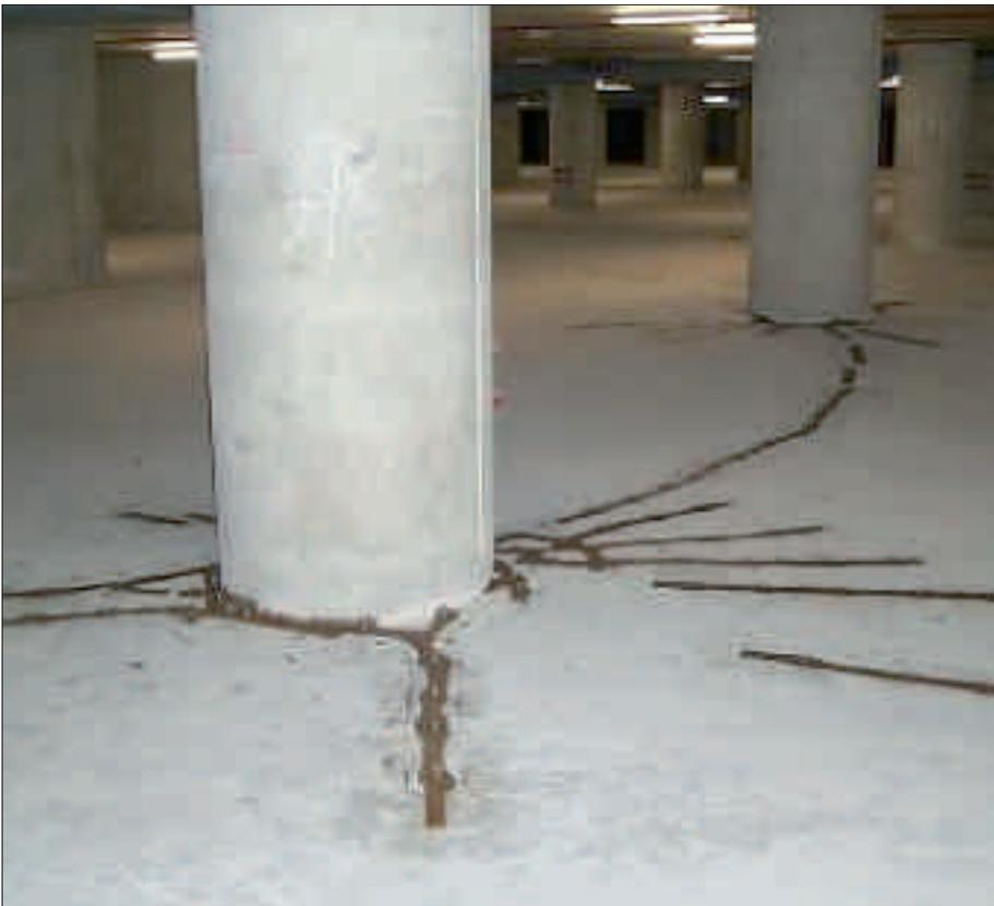
Bild 16: Risse in der Bodenplatte eines Parkhauses
