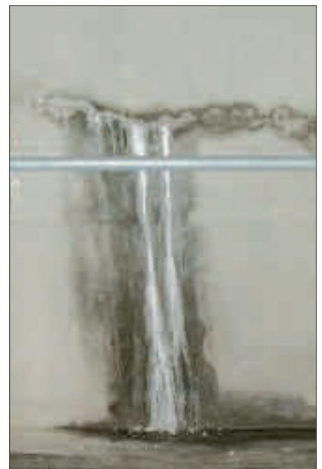
Bild 5: Risse an einer Tunnelschale mit verschiedenen Feuchtezuständen
