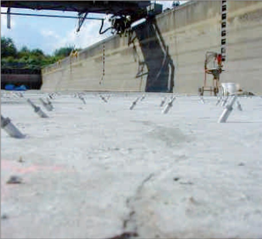
Bild 14: Für die Injektion über Bohrpacker vorbereiteter Riss
