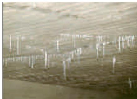
Bild 4: Rissbild an einer Deckenuntersicht mit markanten Merkmalen
