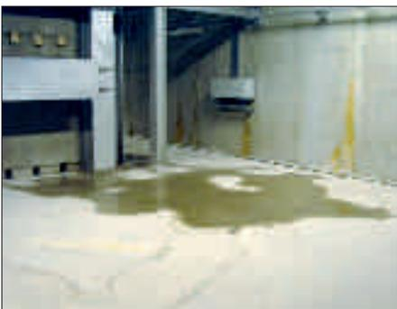
Bild 7: Rissbedingte Nutzungseinschränkungen in einer Industrieanlage
