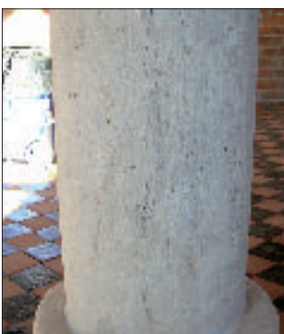
Bild 4: Ton- und Mergel einlagerungen und vertikale Schichtung an den Kalksteinsäulen. Bei den kleinen oberflächennahen Rissen oder feinen Adern handelt es sich um materialtypische Styrolithen. Werden diese nicht durch Wasserzutritt oder Verwitterung geweitet, haben sie i. d. R. nur einen gerinen Einfluss auf die Druckfestigkeit.
