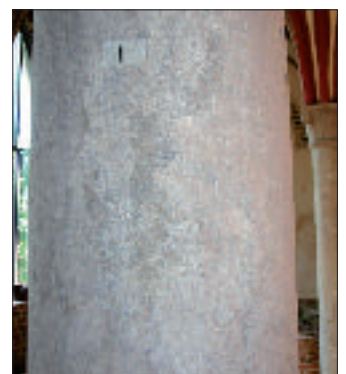
Bild 4: Ton- und Mergel einlagerungen und vertikale Schichtung an den Kalksteinsäulen. Bei den kleinen oberflächennahen Rissen oder feinen Adern handelt es sich um materialtypische Styrolithen. Werden diese nicht durch Wasserzutritt oder Verwitterung geweitet, haben sie i. d. R. nur einen gerinen Einfluss auf die Druckfestigkeit.
