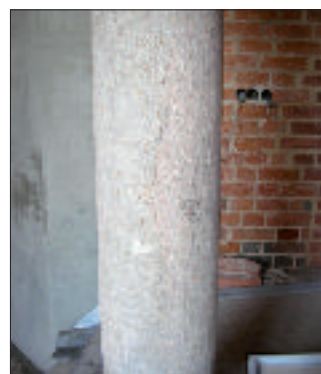
Bild 4: Ton- und Mergel einlagerungen und vertikale Schichtung an den Kalksteinsäulen. Bei den kleinen oberflächennahen Rissen oder feinen Adern handelt es sich um materialtypische Styrolithen. Werden diese nicht durch Wasserzutritt oder Verwitterung geweitet, haben sie i. d. R. nur einen gerinen Einfluss auf die Druckfestigkeit.
