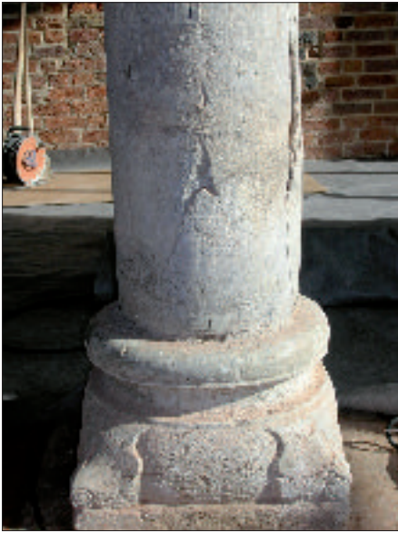
Bild 3: Besonders stark geschädigte Kalksteinsäulen und Basen.
