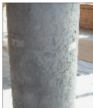
Bild 4: Ton- und Mergel einlagerungen und vertikale Schichtung an den Kalksteinsäulen. Bei den kleinen oberflächennahen Rissen oder feinen Adern handelt es sich um materialtypische Styrolithen. Werden diese nicht durch Wasserzutritt oder Verwitterung geweitet, haben sie i. d. R. nur einen gerinen Einfluss auf die Druckfestigkeit.
