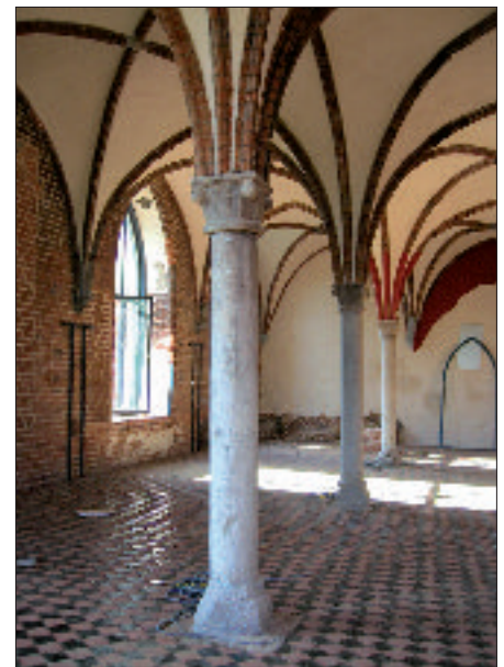
Bild 2: Kalksteinsäulen im ehemaligen Refektorium im Erdgeschoss des Klosters.
