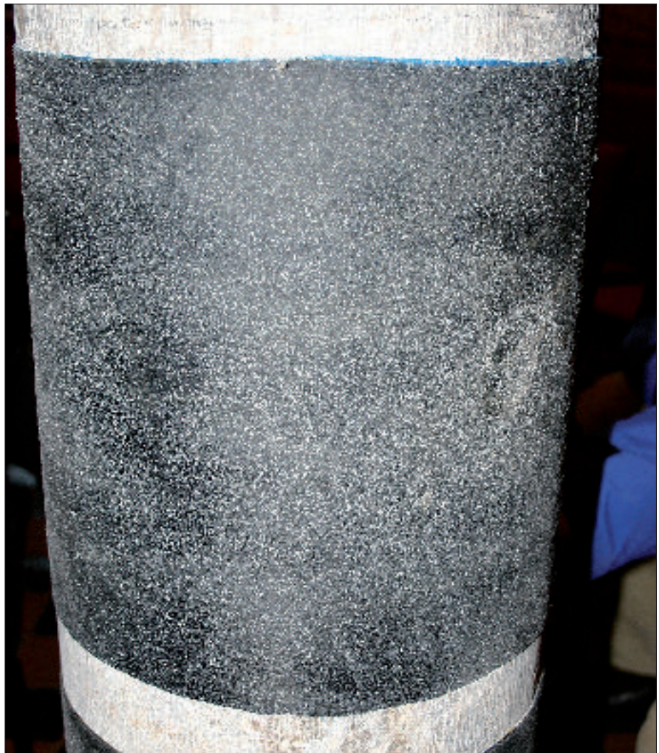
Bild 10: CFK Lamellen zur lokalen Sicherung
