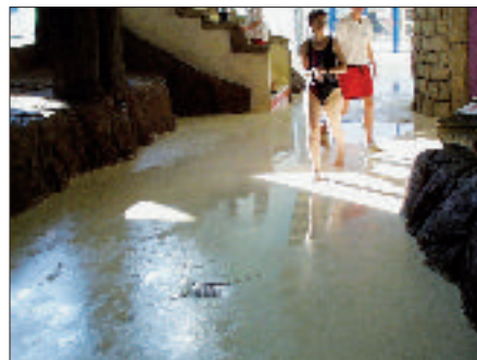
Gefahr durch liegendes Wasser auf Böden
