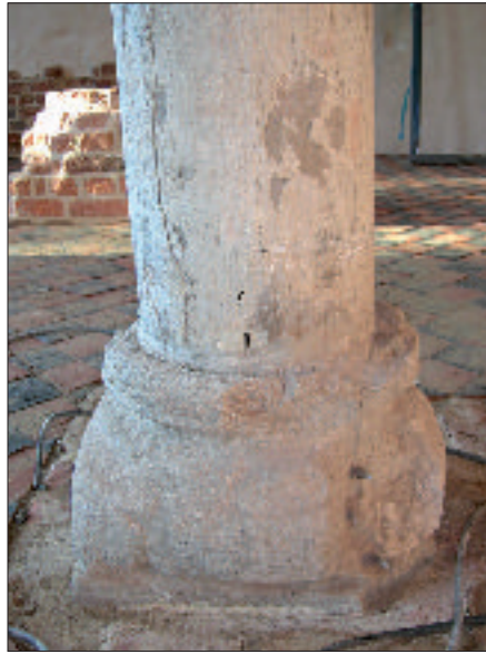
Bild 3: Besonders stark geschädigte Kalksteinsäulen und Basen.
