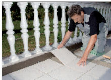
PCI Rapidflott ermöglicht weitestgehend hohlraumfreies Verlegen von Keramik, grossformatigem Steinzeug, Cotto und nicht durchscheinenden Naturwerksteinplatten. Auf das zeitintensive Buttering-Floating-Verfahren kann verzichtet werden.
