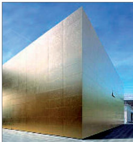
Störungsfreie Oberfläche durch die unsichtbare elastische Verklebung.
