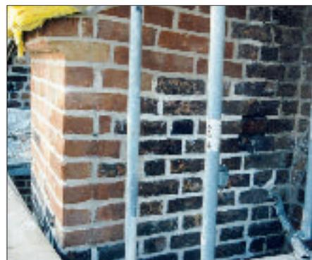
Abb. 17: Sanierung des Mauerwerks am Dom zu Brandenburg mit Sandkalkmörteln
